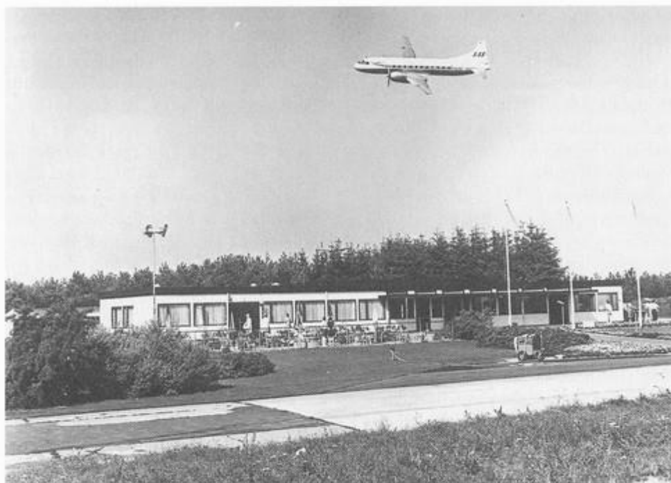
I 1958 blev den militære del af flyvepladsen udbygget til et NATO-anlæg, og i den forbindelse måtte den civile terminalbygning flyttes. Der blev bygget en ny, placeret et stykke vest for den gamle, og den blev som nævnt flere gange ombygget og udvidet i løbet af tresserne og halvfjerdserne. Det er en Metropolitan, der her ses over bygningen, som den så ud i 1971. Foto i Erhvervsarkivet.
